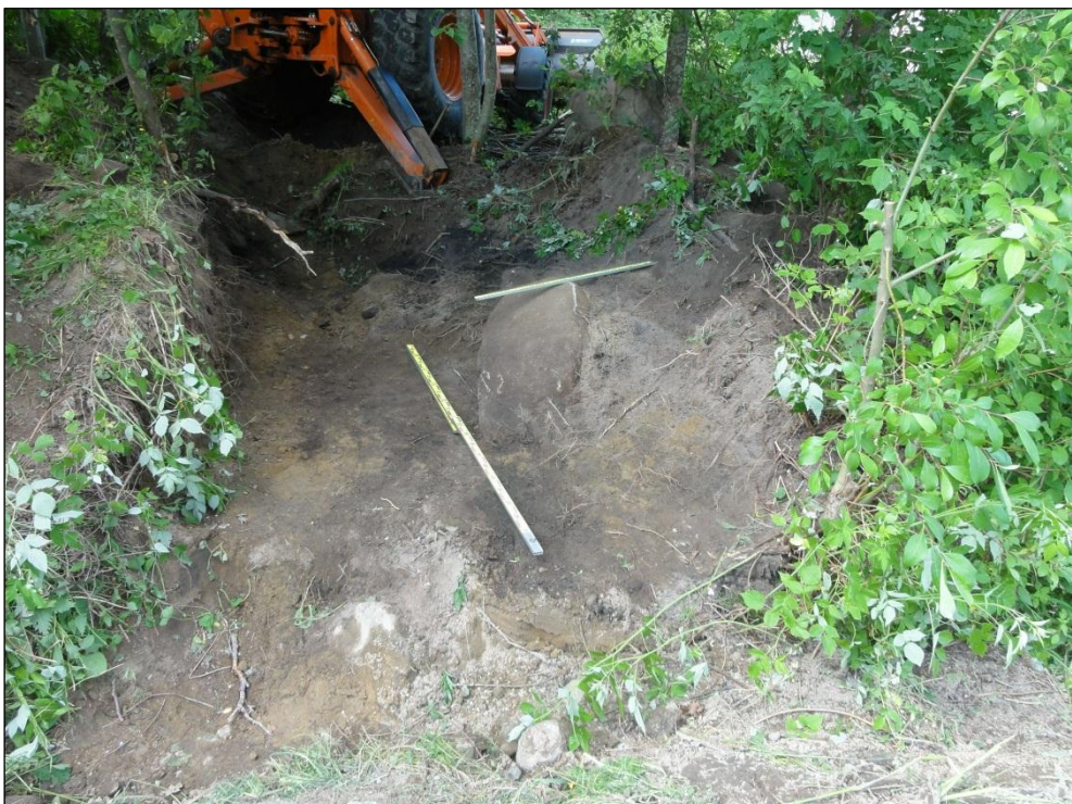
Kuva 5.Koeojan 1 laajennus luoteeseen. Kuva: Antti Bilund
